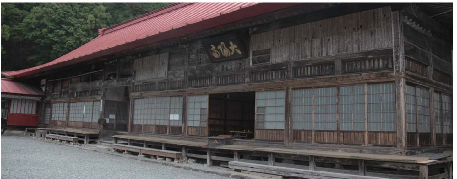
江戸時代に建てられた大陽寺の本堂。宿坊としての客室も兼ねている。
